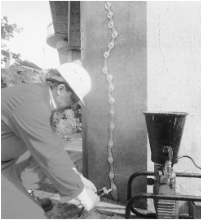
Bild 9: Rissverpressung an einer Stütze (Ph. Holzmann AG)
